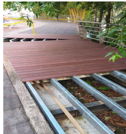
Instalación de madera plástica
